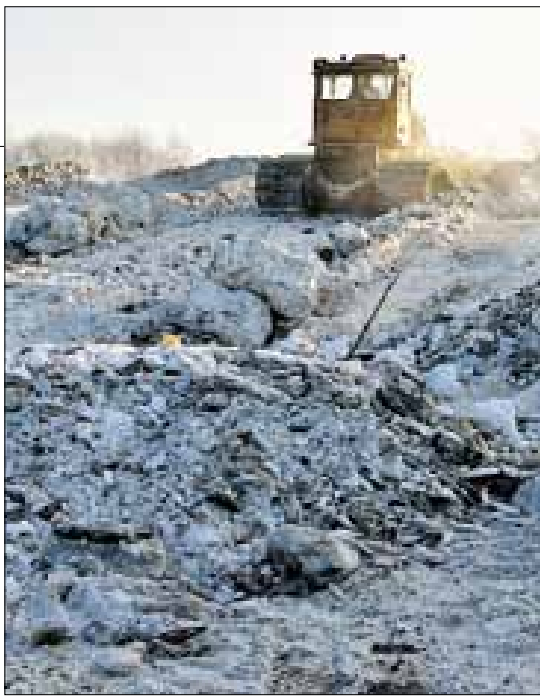
■ Вывезенный снег на полигоне утрамбовывает бульдозер ПДУ. ФОТО: ПРЕСС-СЛУЖБА «ПЛЕСЕЦКОГО ДОРОЖНОГО УПРАВЛЕНИЯ»
