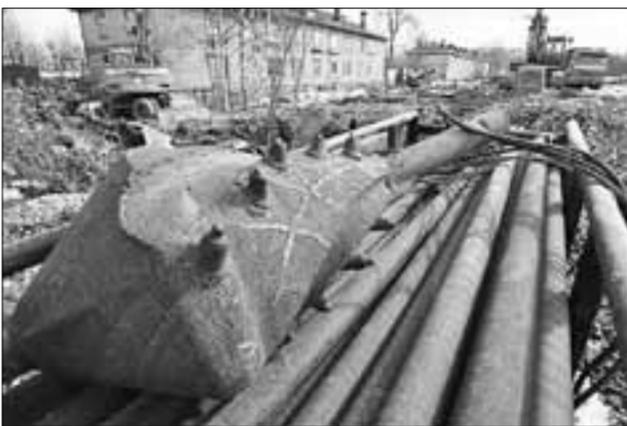
стие протаскивается гильза, и уже в эту гильзу входит основная водопроводная труба. Прокол под асфальтом будет сделан на глубине 2,5 метров.
