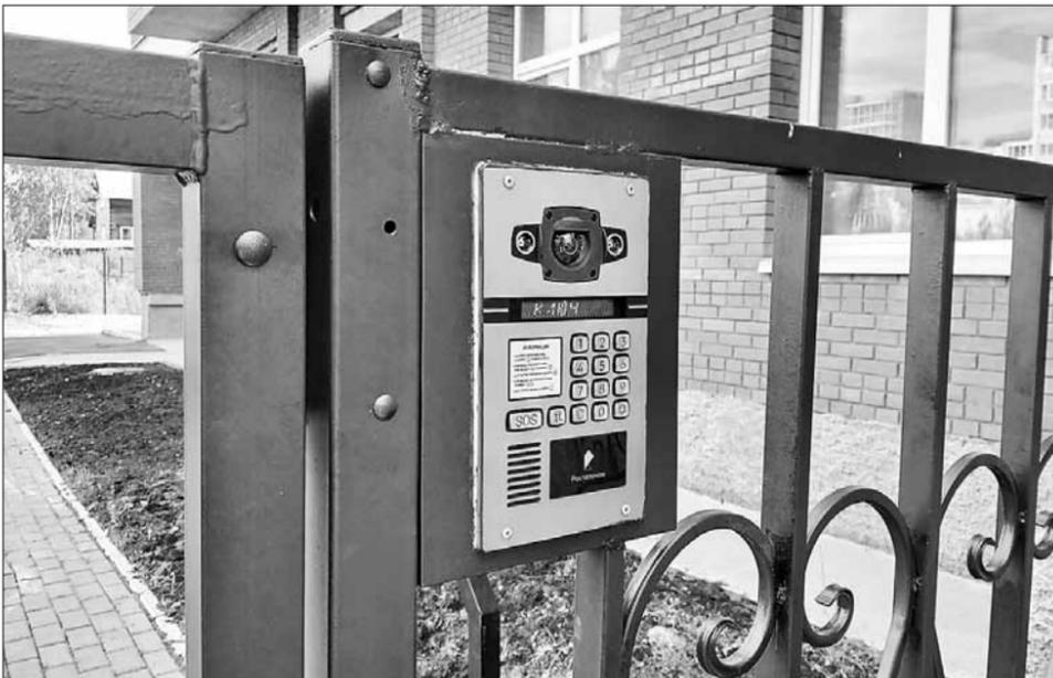
управлять входом в подъезд не только при помощи привычной трубки, но и прямо с экрана смартфона.
