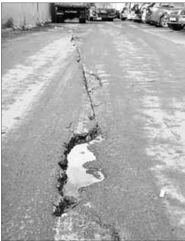
■ Улица Шубина, 3. 18.09.2014 было направлено требование по гарантийному устранению выявленных дефектов до 01.10.2014. Требование не выполнено
