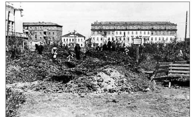
Строительство убежищ в Архангельске
