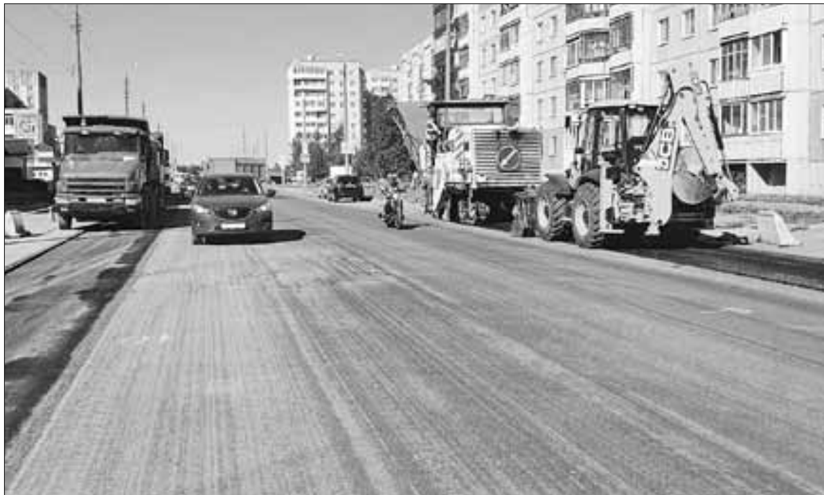
■ Фрезерование дорожного покрытия на улице Галушина
