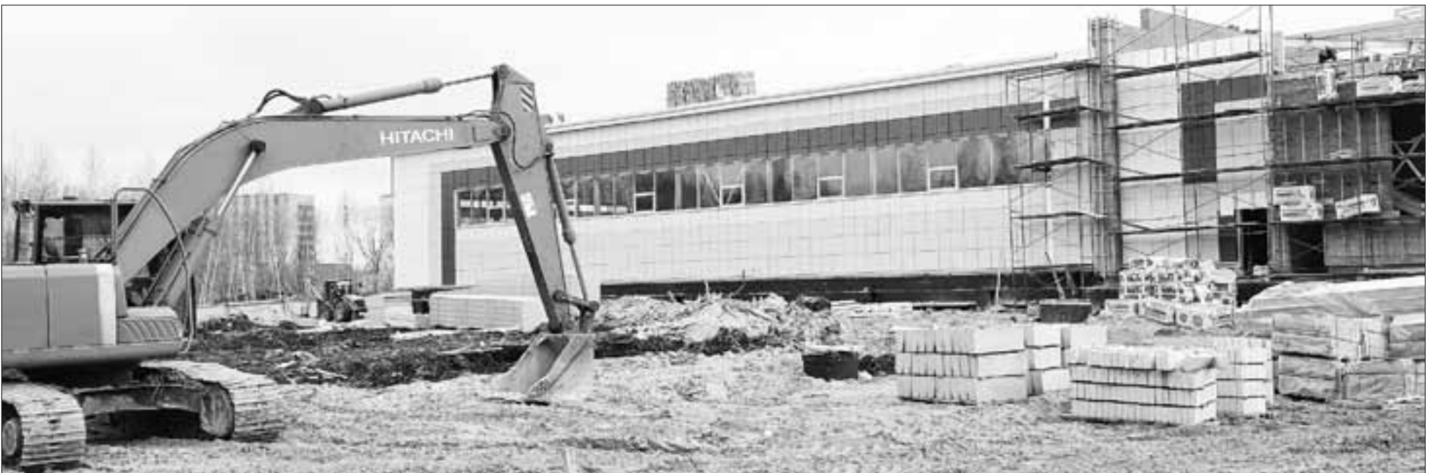
■ Строящийся ФОК в округе Варавино-Фактория
