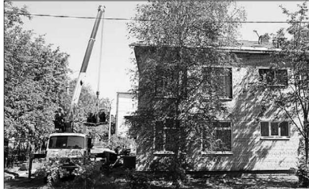
**В детском саду № 66 полным ходом идут работы по ремонту кровли – вместо старого шифера здесь будет долговечная и надежная металлочерепица.**
