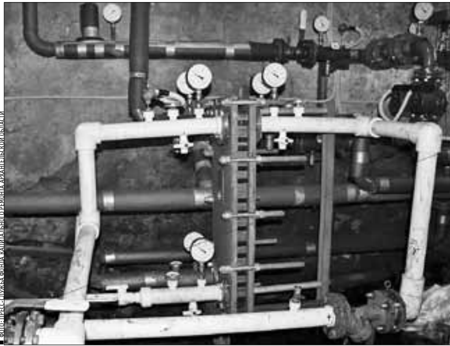
ФОТО: ПРЕСС-СЛУЖБА ФОНДА КАПИТАЛЬНОГО РЕМОНТА АРХАНГЕЛЬСКОЙ ОБЛАСТИ
