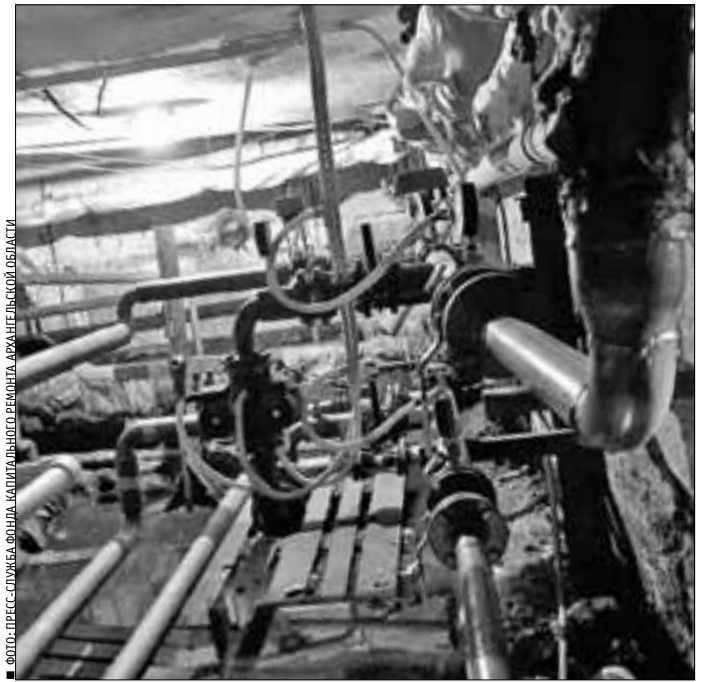
ФОТО: ПРЕСС-СЛУЖБА ФОНДА КАПИТАЛЬНОГО РЕМОНТА АРХАНГЕЛЬСКОЙ ОБЛАСТИ
