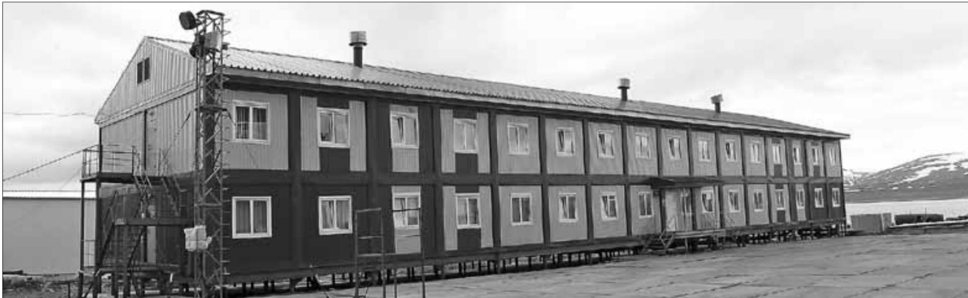
■ Такие здания на Новой Земле возводятся по технологии модульного домостроения. ФОТО: АРХИВ «АРКТИКСПЕЦМОНТАЖ»
