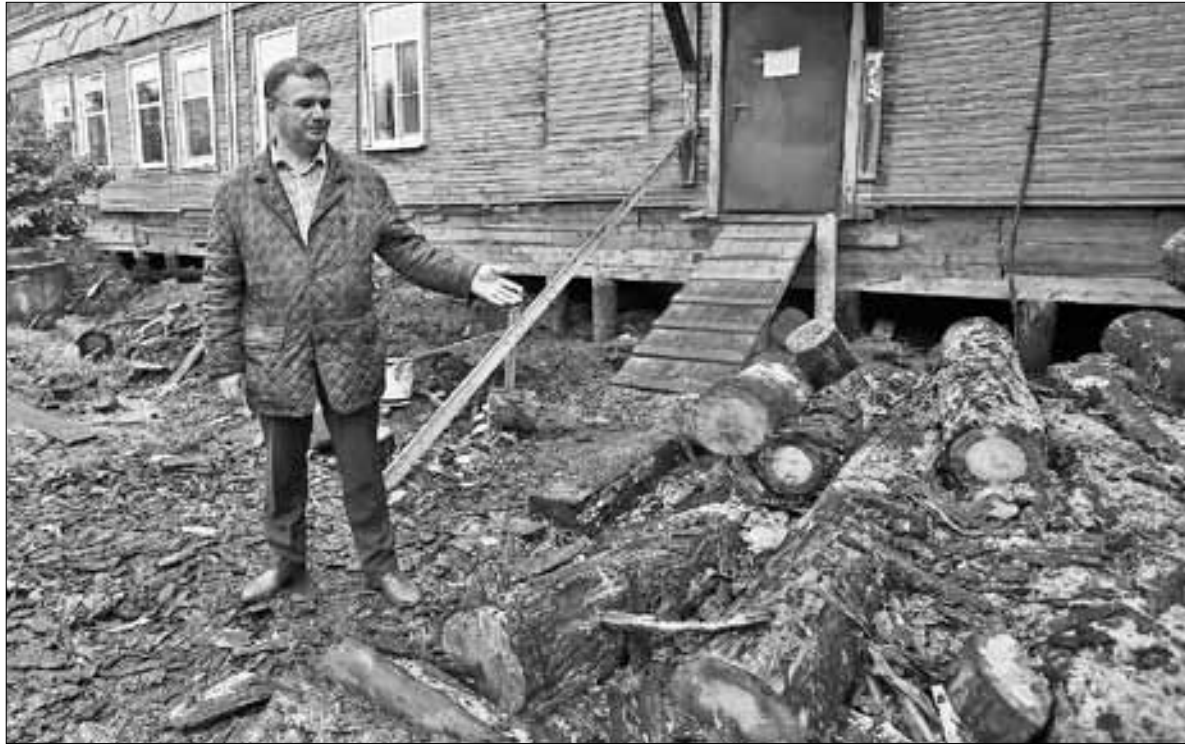
■ К обслуживанию «деревяшек» УК «Мегаполис» относится ответственно. Директор компании Константин Вебер рассказывает о ремонте свайного основания большого дома в Соломбале
