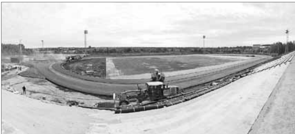
■ Строящийся стадион в Северном округе
