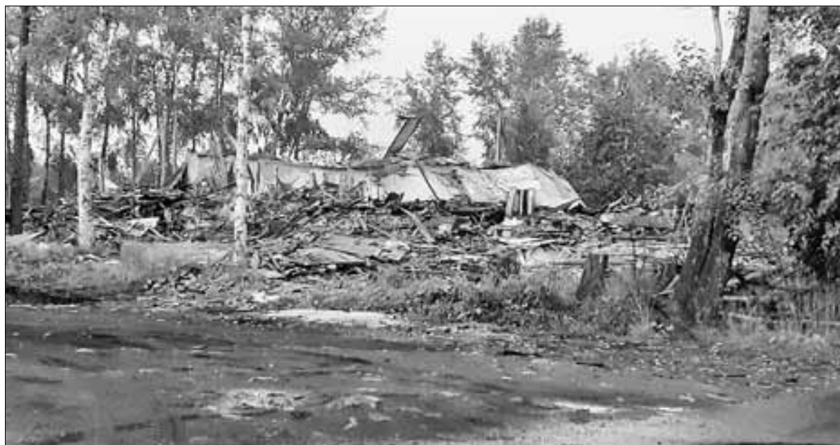
■ Все территории на месте снесенных домов в Маймаксанском округе должны быть зачищены до 15 ноября 2020 года. ФОТО: «ОТКРЫТЫЙ ЧАТ» В СОЦСЕТИ «ВКОНТАКТЕ»
