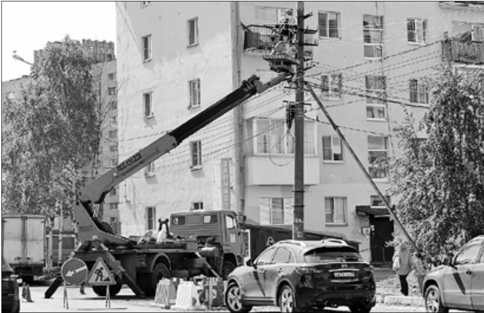
■ МУП «Горсвет» заменило вдоль проспекта Ломоносова 40 аварийных опор, еще 19 выправило по вертикали. Установлено более 100 современных светодиодных светильников
