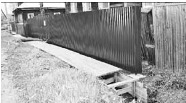
■ ТОС «Кемский» привел в порядок дренажно-ливневую канализацию на ул. Суханова. ФОТО: КСЕНИЯ НАЙДИЧ
